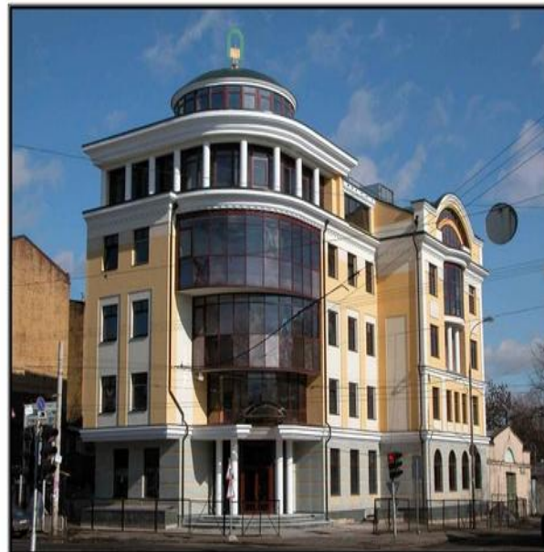
Строительство административного здания (г. Москва, ул. Дубининская, д.43) Заказчик: ЗАО «ОстИнвестСтрой»
