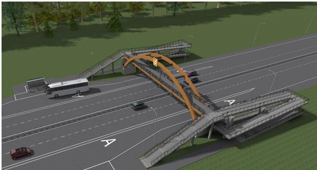
Пешеходный переход открытого типа, пролетное строение выполнено в виде арки из клееной древесины с ходьбой посередине. Полная длина пролета  $L=36,8$  м.
