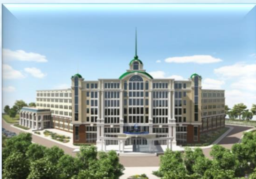
Административный комплекс ООО «Газпром трансгаз Ухта»
