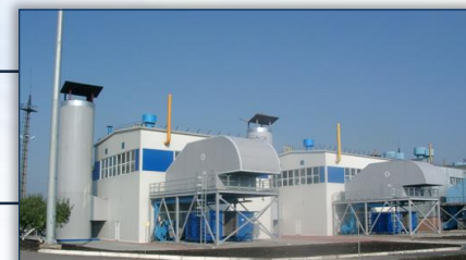
Курская КС. Компрессорный цех №1
